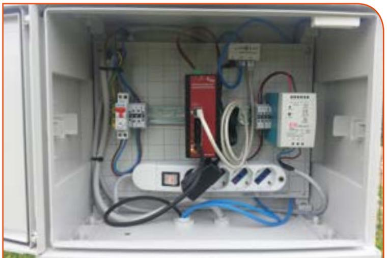
■ **Il modulo wireless è collegato alla Vigilanza con doppio canale di trasmissione: il polling continuo verifica la corretta funzionalità del collegamento al campo**
