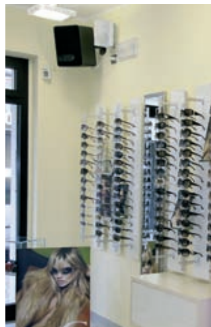
Nebbiogeno a protezione di un negozio di ottica. Courtesy Bandit
