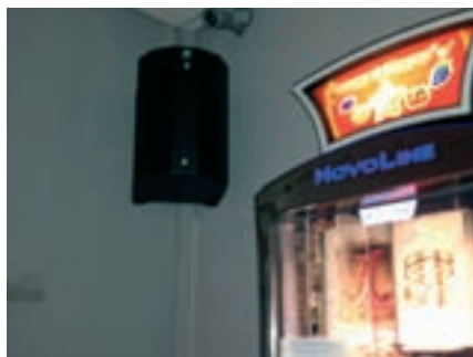
Nebbiogeno a protezione di slot machine. Courtesy: Ur Fog
