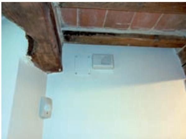
All'interno è stata realizzata una completa protezione volumetrica con rivelatori a doppia tecnologia, che controllano tutta la superficie del negozio.
