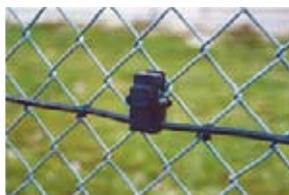
Cias introduce sul mercato ISC (infinity sensor cable) ampliando, con questa tecnologia complementare, la gamma prodotti offerta con le sue già famose barriere a microonde, infrarosso ecc. ISC è un sistema perimetrale
